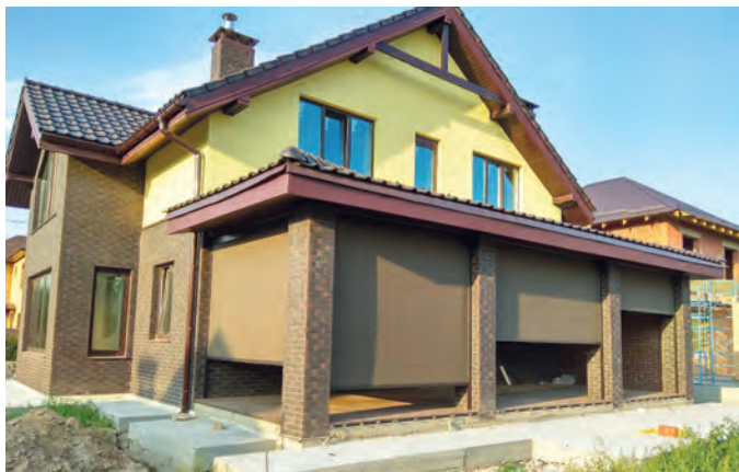
Внешняя солнцезащита - вертикальные маркизы. Объект в Киевской области
