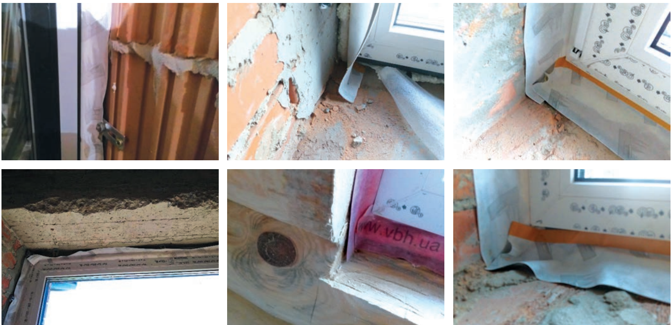
Рис.5. Выполнение тёплого монтажа в неподготовленный проём - обман покупателя
