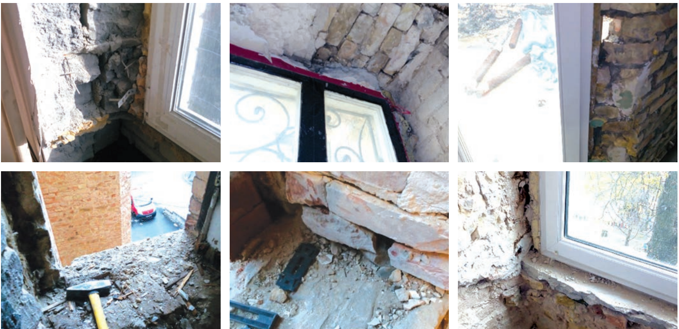
Рис.1. Вскрытие откосов в старых домах. Монтаж окон в такие проёмы - надругательство над строительными нормами
