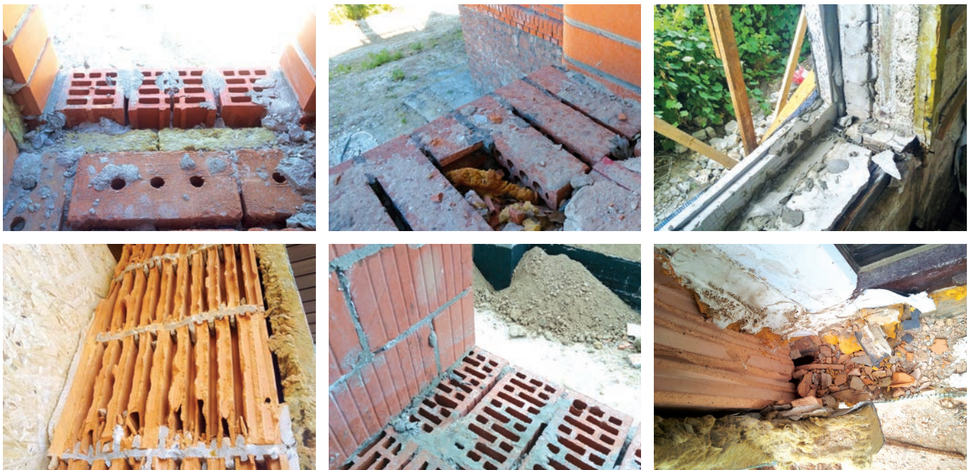
Рис.3. Состояние кладки во многих современных коттеджах
