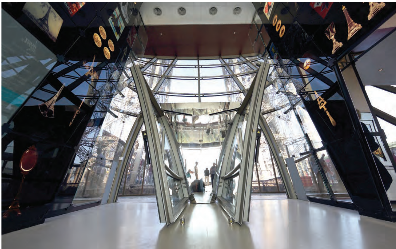
Каждый из изолирующих стеклянных элементов весит 950 килограмм
