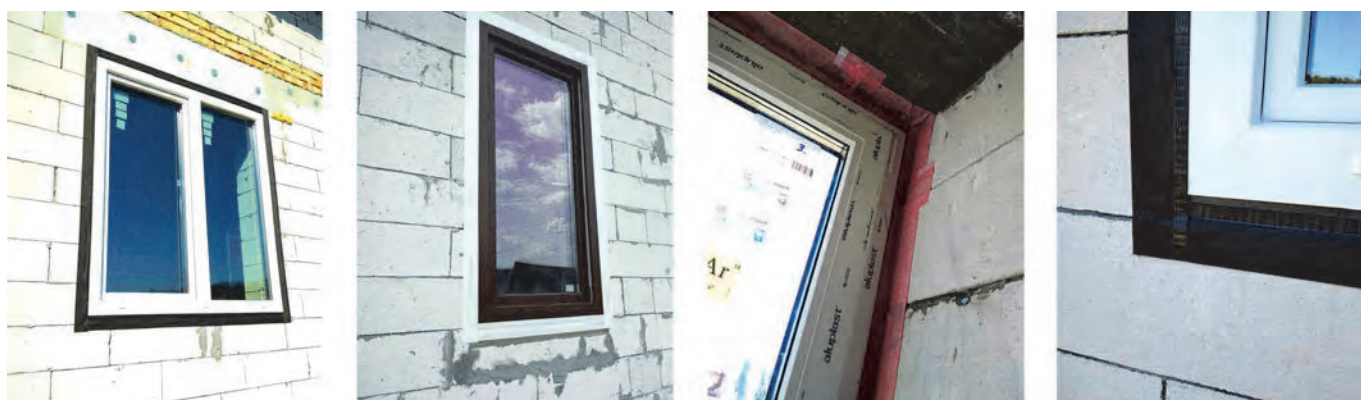
Рис. 7. Монтажні ситуації на об'єкті
