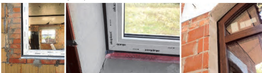
Рис. 10. Монтаж вікон на стрічку ПСУЛ
