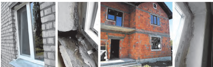
Рис. 8. Монтаж вікон в не підготовлені прорізи
