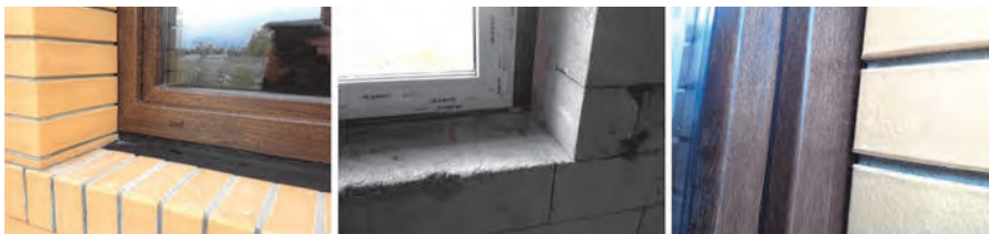
Рис. 9. Монтаж вікон в стіну з чвертю
