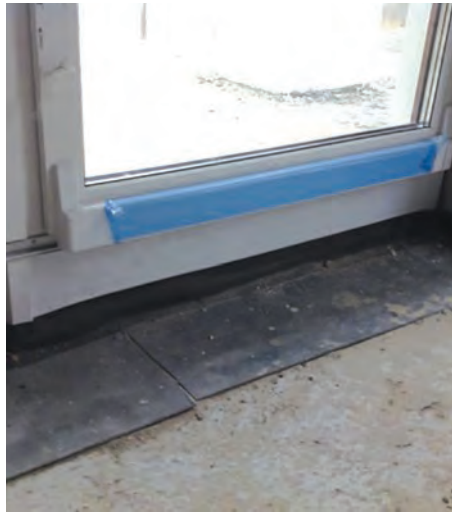
Рис. 13. Облаштування терморозривів в стьяжах під порогами дверей та вітражів
