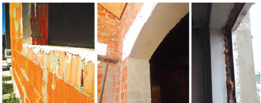
Рис. 5. Монтажні ситуації на об'єкті
