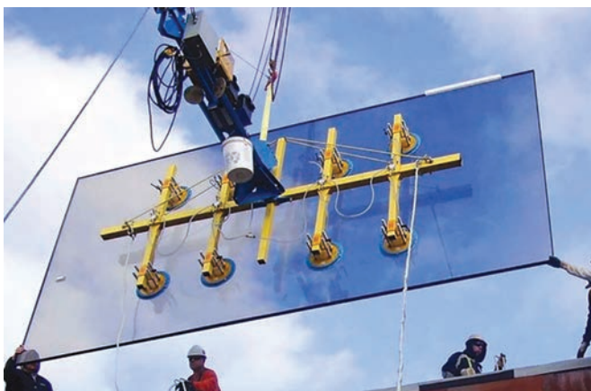
Пример неучтенных нагрузок на стеклопакеты больших размеров
