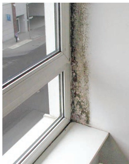
Видимый ход изотермы 13°C. Полоса плесени указывает, где нужно было монтировать оконный блок.
