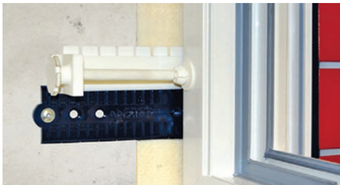
Оснастка для позиціонування рами в прорізі при монтажі вікон на Опорні Консоли FOPPE_VSThermo.
