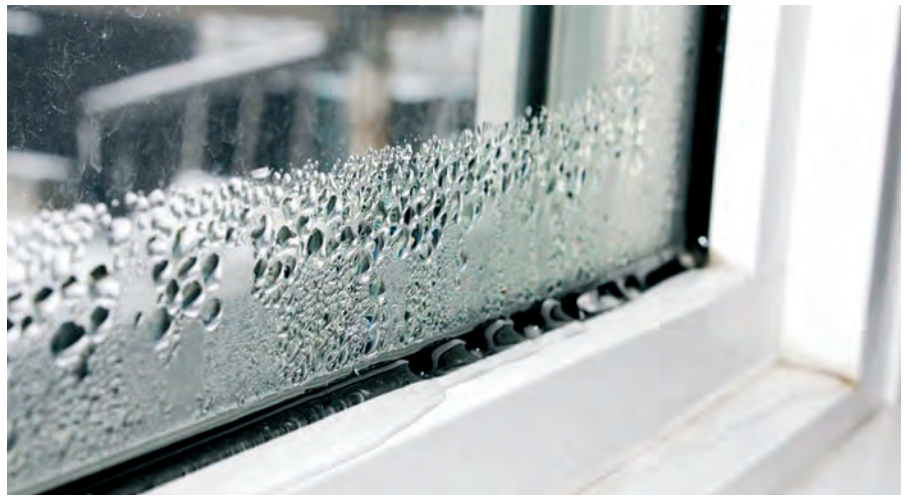
Запотівання вікна з боку приміщення або поява конденсату на внутрішній частині вікна
