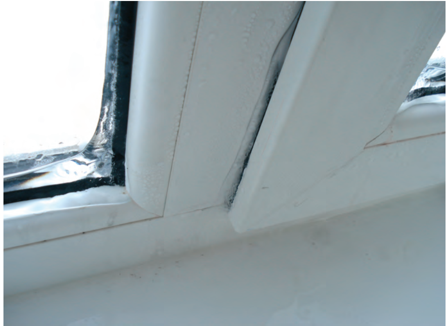
Обмерзання внутрішньої частини вікна
