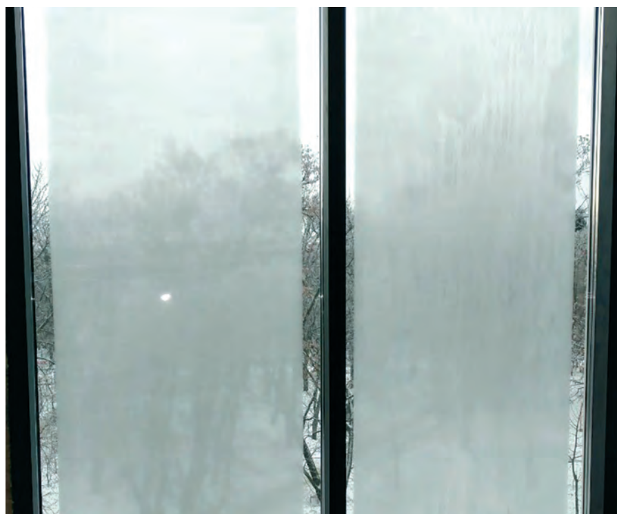
Зовнішнє запотівання випаровується до середини
