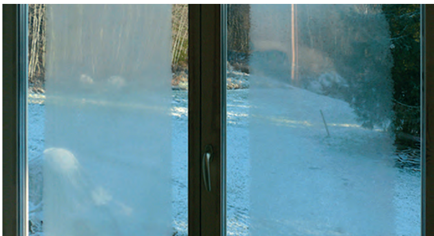
Поява конденсату (запотівання) всередині склопакета
