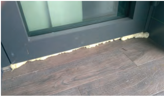
Вікна та двері встановлені на стяжку, яка наскрізь з'єднується з вулицею.
