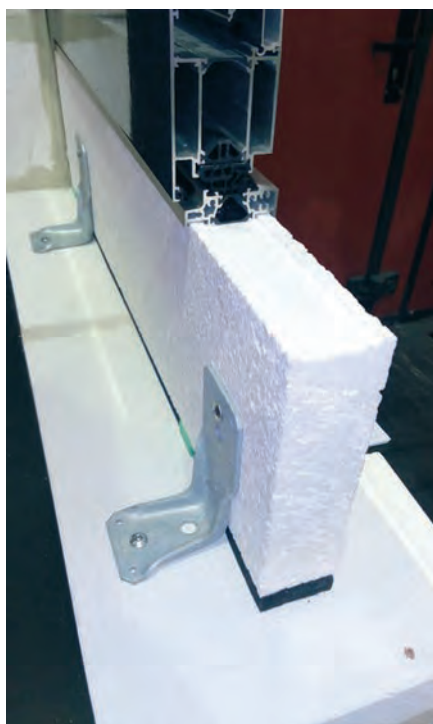
Приклади терморозриву порогів в різних віконних і монтажних системах.
