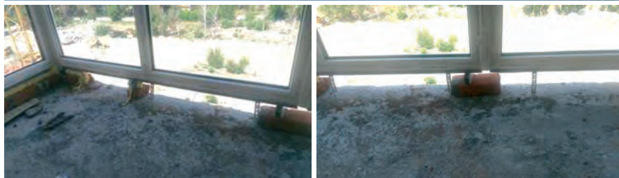
Типовий монтаж панорамних вікон і балконів в новобудові.
