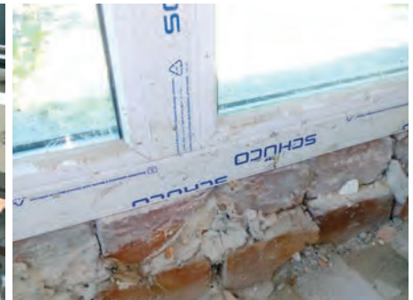
На фотографії поріг, який не тільки стоїть на стяжці, яка виходить на вулицю, але і немає ні нормального монтажного зазору, ні утеплювача на примиканні.
