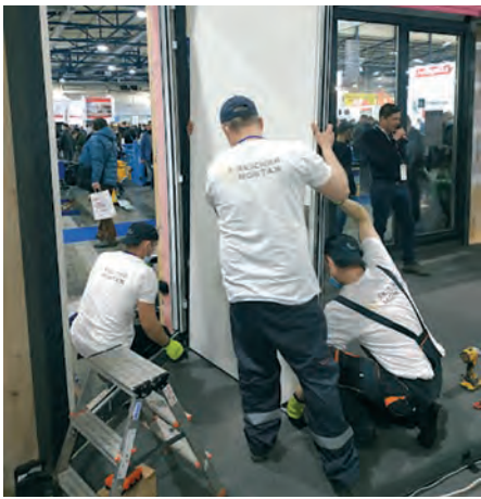
«Виносний» монтаж в зону утеплювача на виставці ІнтерБілдЕкспо 2021
