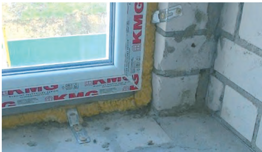
Вікна та двері просто встановлюються на підлогу, яка виходить на вулицю, на балкон або на терасу без будь-якого терморозриву.
