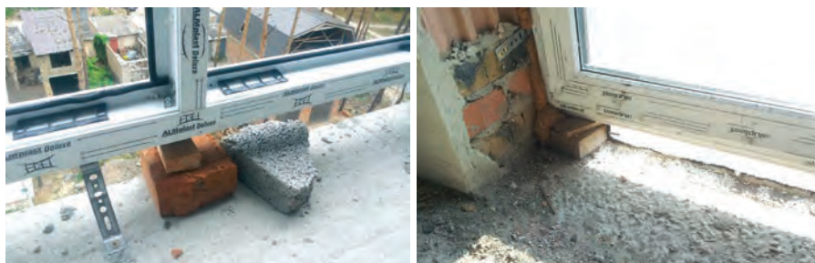
Вікна та двері просто встановлюються на підлогу, яка виходить на вулицю, на балкон або на терасу без будь-якого терморозриву.
