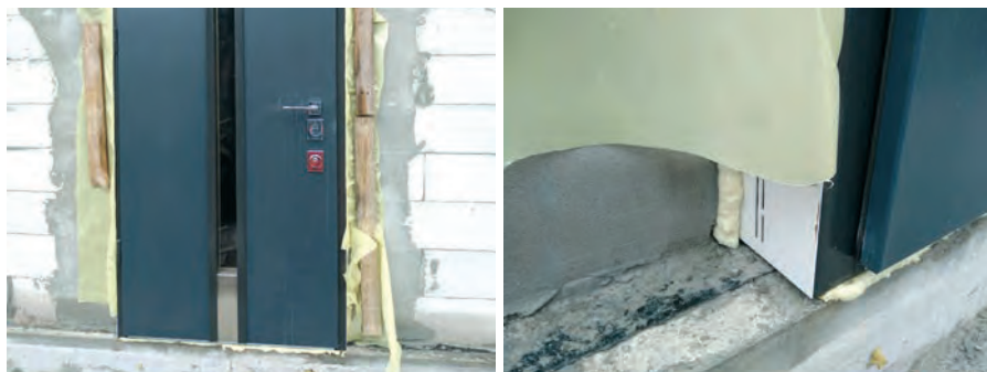
Холодний металевий поріг вхідної групи, так званих «бронедверей», як це часто буває встановлений прямо на чистову стяжку.
