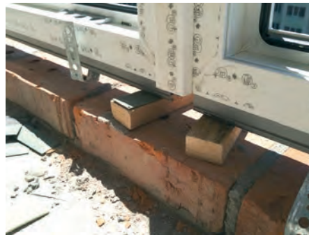
На фотографії поріг, який не тільки стоїть на стяжці, яка виходить на вулицю, але і немає ні нормального монтажного зазору, ні утеплювача на примиканні.
